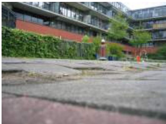
Figuur 1.1 Zakkingsproblemen in Gouda, rechts: putdeksels die boven het wegdek uitkomen.
