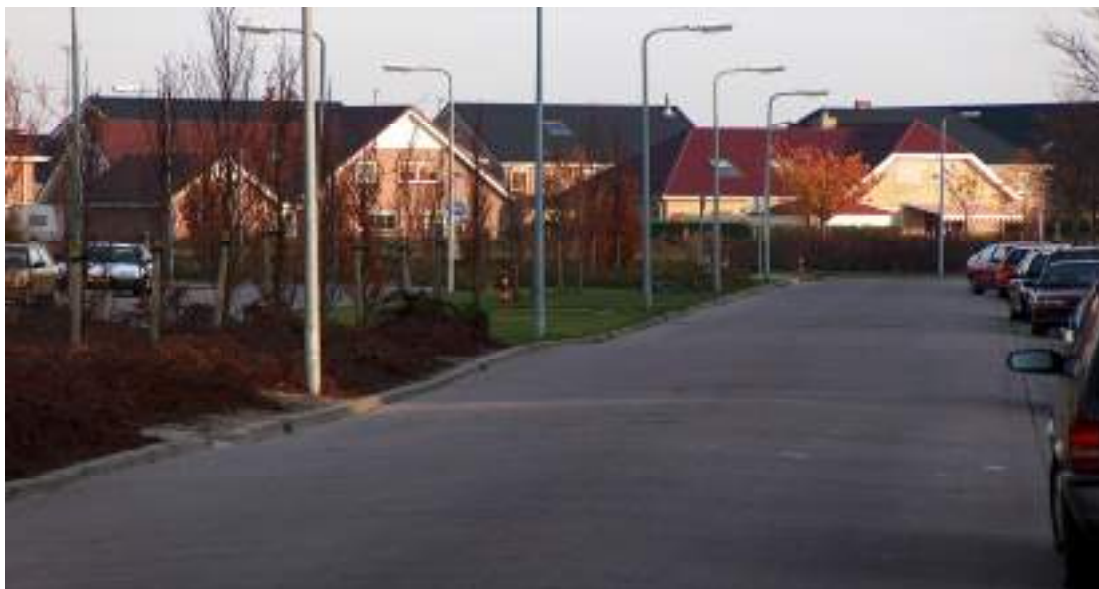
Figuur 2.5 Verzakingsproblemen te Urk met als gevolg gebroken rioleringen
