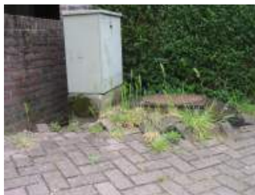
Figuur 1.1 Zakkingsproblemen in Gouda, rechts: putdeksels die boven het wegdek uitkomen.
